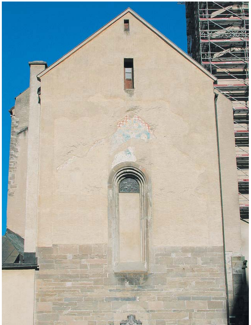
Abb. 72: Chur, Kathedrale St. Mariä Himmelfahrt. Ostfassade des Altarhauses, Zustand 2003.
