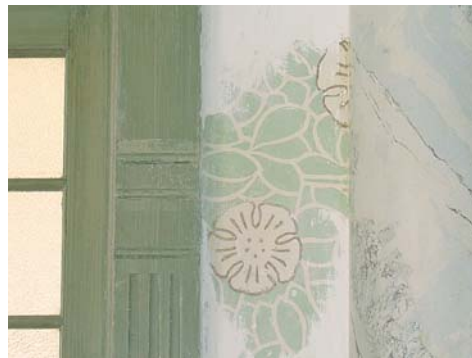
Abb. 134: Bergün/Bravuogn, «Kurhaus Bergün». Reststück der ehemaligen Wandbemalung im Vestibül.
