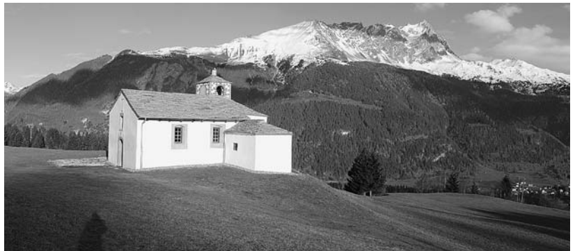
Abb. 81: Riom-Parsonz, Salaschings, Kapelle St. Bartholomäus. Nach der Restaurierung. Zustand 2004. Blick gegen Nordosten.
