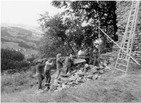
Abb. 53: Sils i. D., Burganlage Hohenrätien. Mauersicherung bei der West-Ecke der Burganlage. Mitarbeiter des ADG und Freiwillige transportieren einen Eckstein. Blick gegen Norden.
