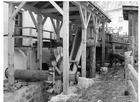
Abb. 148: Sta. Maria V. M., Mühle Mall. Die Antriebskonstruktion der Mühle mit Holzkanal und unterschlächtigem Strauberrad, welches den Mahlgang im Innern antreibt.
