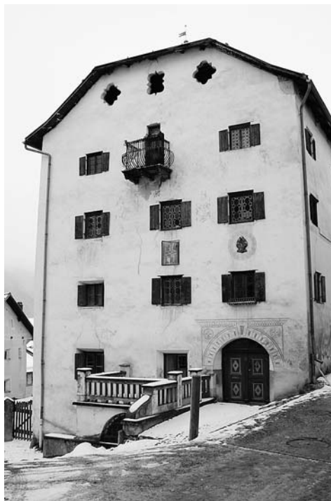
Abb. 155: Gebäudeinventar. Ardez, Haus Nr. 120. Ost- fassade.
