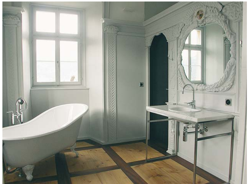
Abb. 146: Zizers, Oberes Schloss, Hauptgebäude. Das Alkovenstübchen im ersten Obergeschoss, heute Baderaum.
