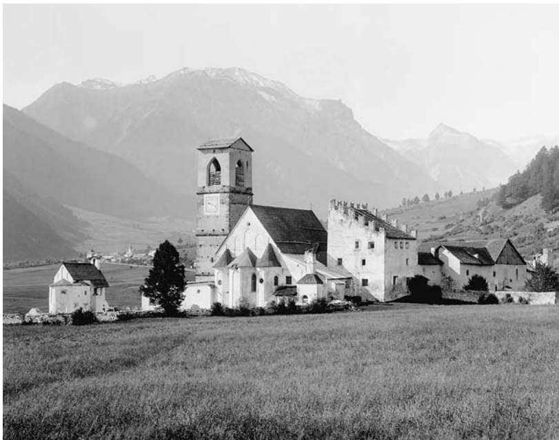
Abb. 68: Müstair, Kloster St. Johann. Die Klosteranlage von Nordosten mit Heiligkreuzkapelle, Klosterkirche, Plantatum und Nordtrakt. Historische Aufnahme vor 1906. Mit Ausnahme des Schlepddachs über dem Nordannex und der Sakristei sowie des Dachs über der südseitigen Kapelle sind noch alle Dächer mit Holzschindeln gedeckt.
