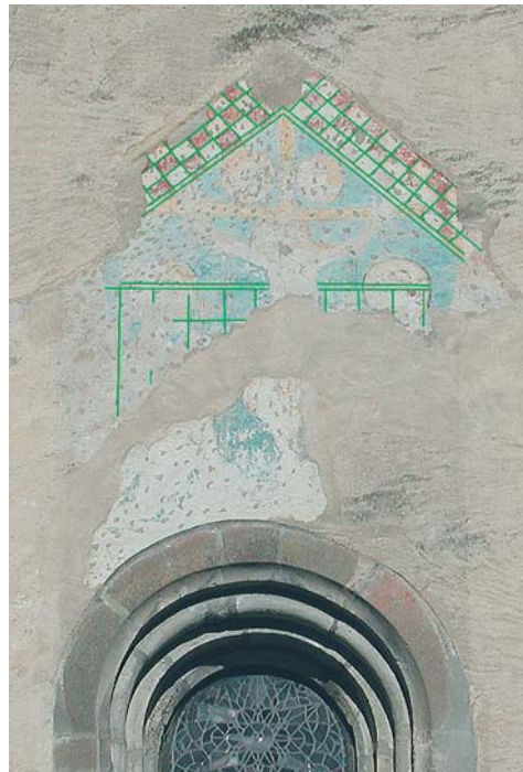
Abb. 74: Chur, Kathedrale St. Mariä Himmelfahrt. Kreuzigungsdarstellung an der Ostfassade des Altarhauses. Grün eingezeichnet die Ritzlinien im hochgotischen Malputz.
