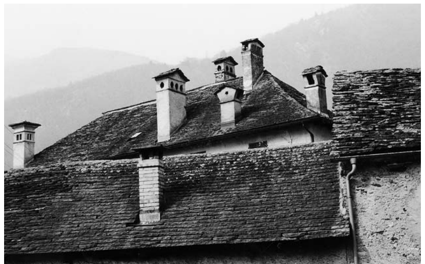
Abb. 119: Roveredo, Haus Toveda. Steinernes Walmdach mit Kaminen.
