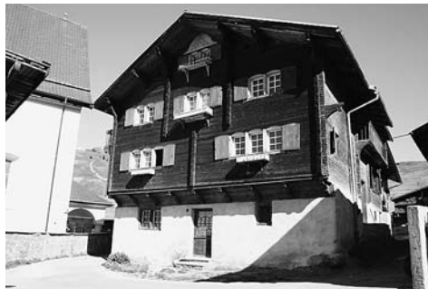
Abb. 154: Gebäudeinventar. Lumbrin, Haus Nr. 111. Südfassade.
